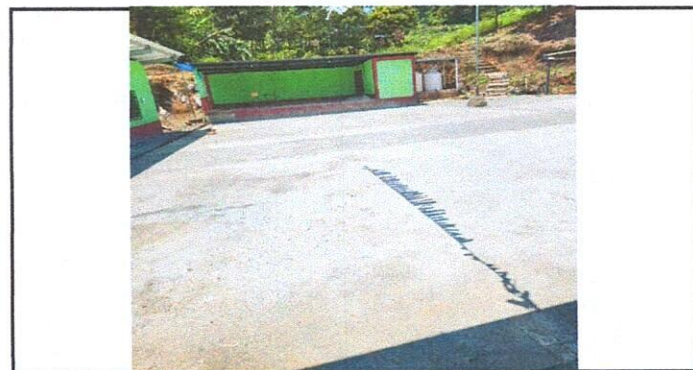
Foto 6: LOSA DE PATIO
