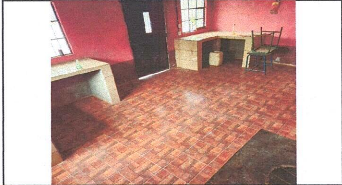
Foto 2: SUSTITUCION DE PISO DE CEMENTO POR AZULEJO
